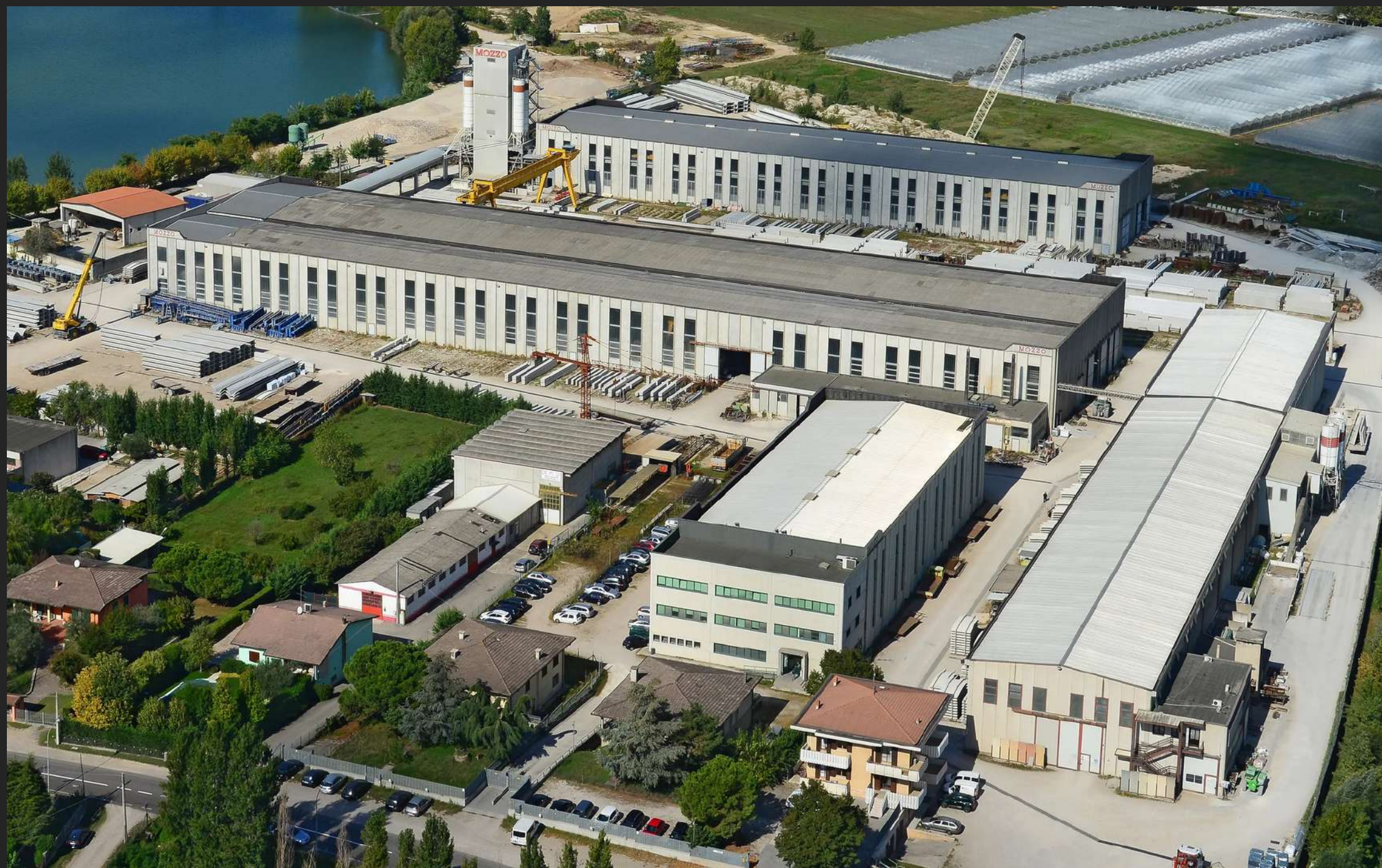
Sede Mozzo Prefabbricati S.r.l di Zevio (VR)
